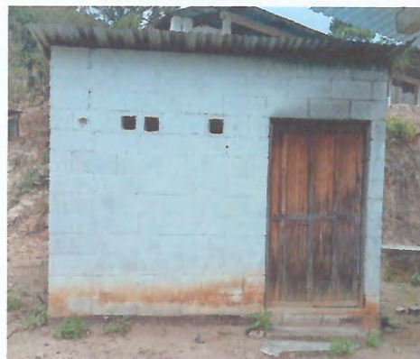
Foto 2: Sustitución de una puerta de madera a metálica .
