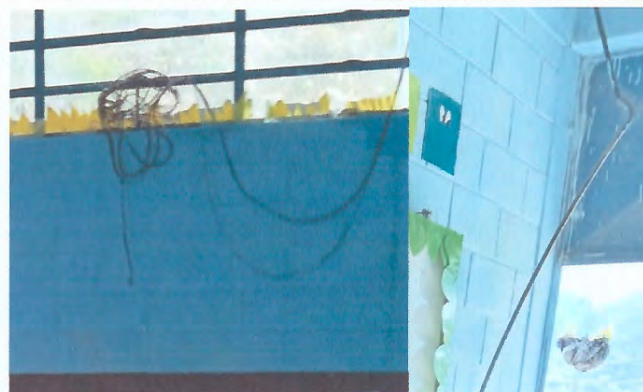
Foto 4: Mejoramiento e intalación del sistema eléctrico.
