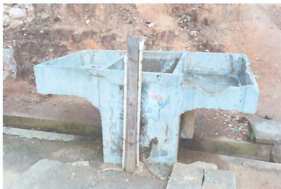
Foto 3: Mejoramiento e instalación de una pila.
